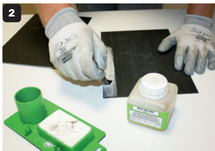
2 Premier décapage au Deca VMZINC.
