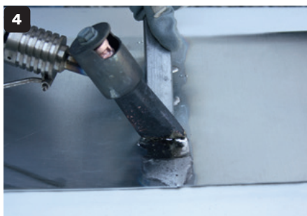
Réalisation d'un étamage (si épaisseur > 0,8 mm). Ensuite redépose du métal d'apport (si épaisseur > 0,8 mm).
