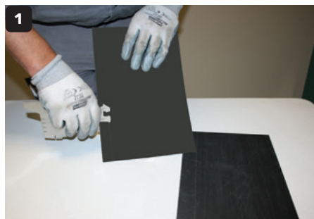
1 Traçage des valeurs de recouvrement.
